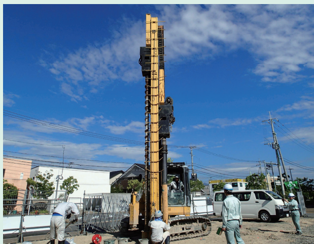
写真-1 施工状況
